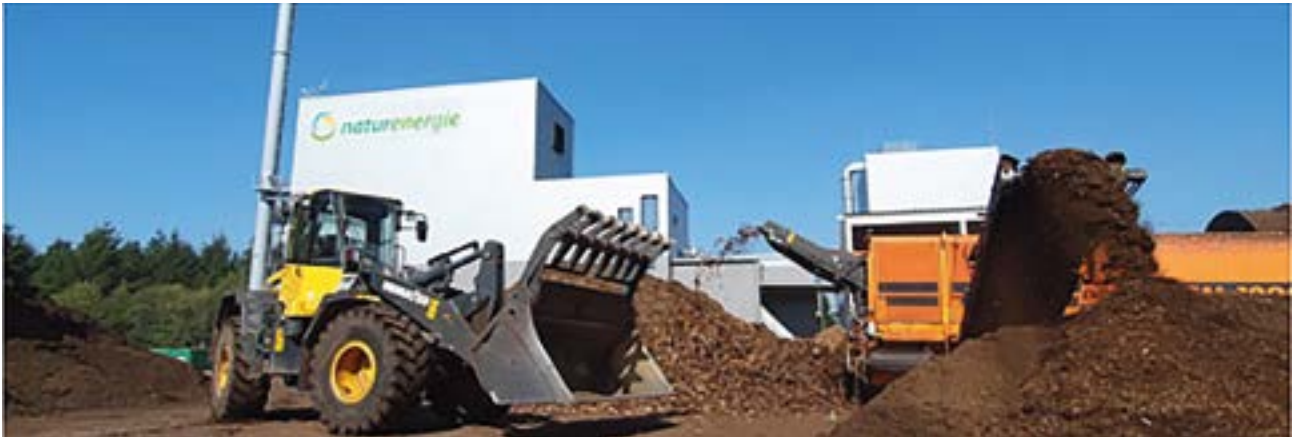
Abb. 22: Biomasseheizkraftwerk in Heidenrod-Kemel, Quelle: Rheingau-Taunus-Kreis
