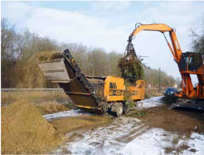
Rest- und Abfallstoffe bieten Potenzial zur energetischen Nutzung.
